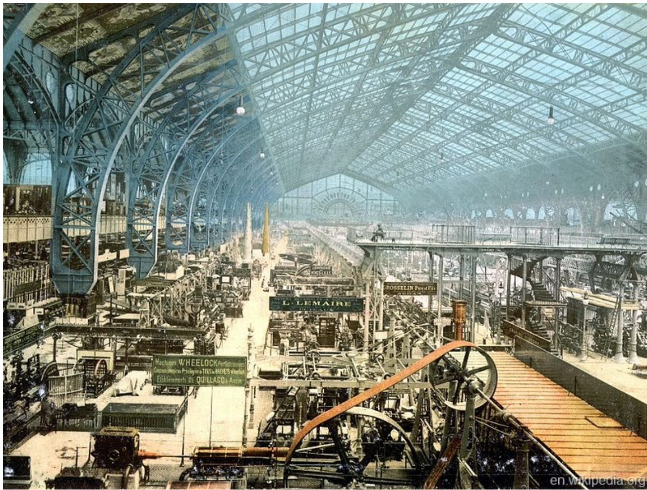
Exposição Universal de Paris. 1889. Galeria de Máquinas. Arquiteto Ferdinand Dutert , engenheiro Victor Contamin
