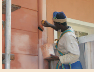
10.06.08 1º demão de pintura a base de cal – cor branca para fundo (uniformidade).
