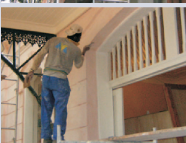
13.06.08 Após parte da pintura ter secado, iniciou-se o processo de lixar a 2ª demão de tinta, para aplicação da 3ª
