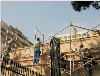
26.05.08 Restauração das fachadas – Colocação da pingadeira de cobre na cimalha.
