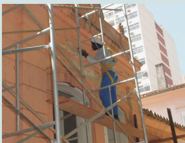
29.02.08 remoção de pintura da fachada
