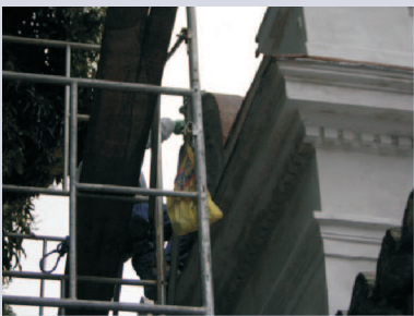
10.06.08 1º demão de pintura a base de cal – cor branca para fundo (uniformidade).
