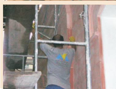
13.06.08 Após parte da pintura ter secado, iniciou-se o processo de lixar a 2ª demão de tinta, para aplicação da 3ª
