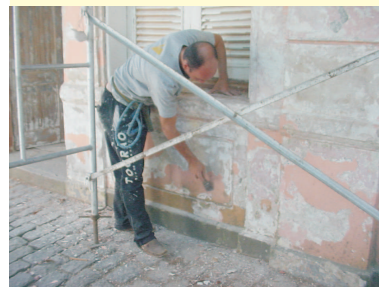
31.03.08 remoção com espátula das antigas demãos de pintura
