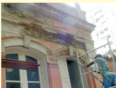
25.03.08 remoção da argamassa comprometida
