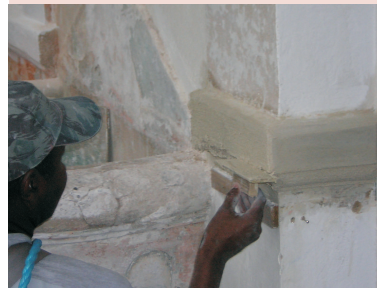
30.05.08 Repasse de argamassa nas áreas onde houve remoção de argamassa irregular
