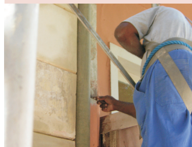
03.06.08 Remoção de tubo desativado existente na fachada.
