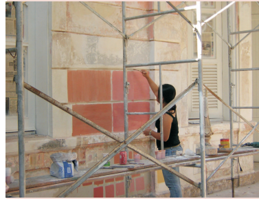
28.05.08 Restauração das fachadas – Teste de pintura conforme solicitado
