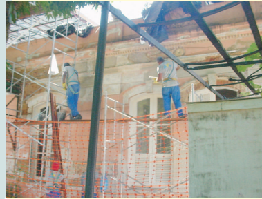
28.03.08 repasse da argamassa a base de cal nas áreas onde houve a remoção de reboco
