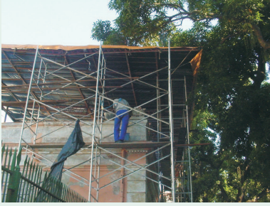
25.04.08 remoção de argamassa irregular (que não é de cal)
