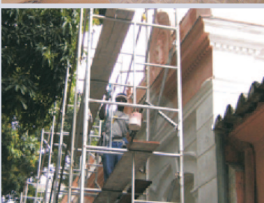
13.06.08 2º demão de pintura a base de cal – cor rosa, aplicada sobre pintura a base de cal.
