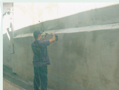
14.04.08 retirada de argamassa irregular (que não é de cal, fachada fundos – estacionamento FCRB).
