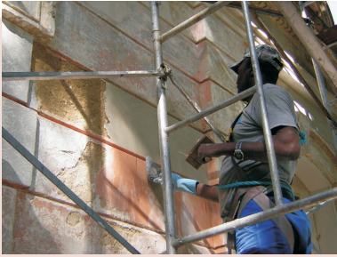
14.05.08 repasse de argamassa nas áreas onde houve remoção de argamassa irregular
