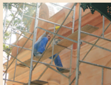
13.06.08 2º demão de pintura a base de cal – cor rosa, aplicada sobre pintura a base de cal.
