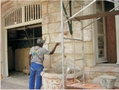
16.05.08 remoção com espátula das antigas camadas de pintura
