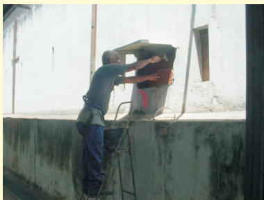
04.03.08 Fechamento dos vãos de ar condicionado
