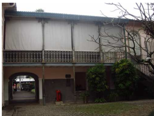
Fachada Norte – vista geral do Lambrequim
