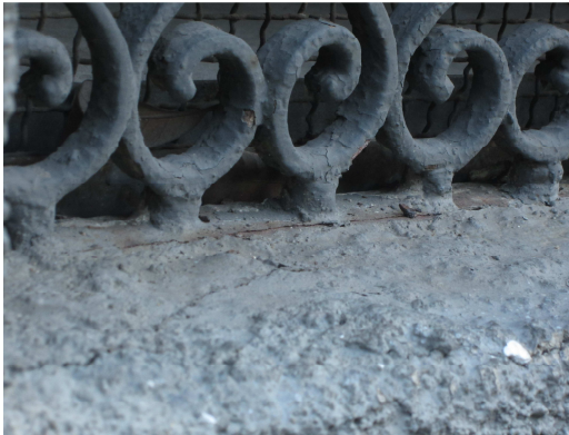
Fixação do gradil na parede do vão
