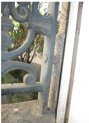
Fixação no piso
