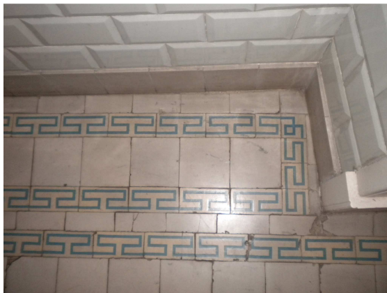
Soleira também apresenta o ladrilho hidráulico
