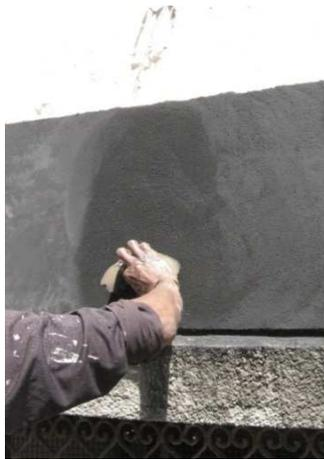
Figura 126: Superfície sendo camurçada com o auxílio de uma esponja (28/09/11).
