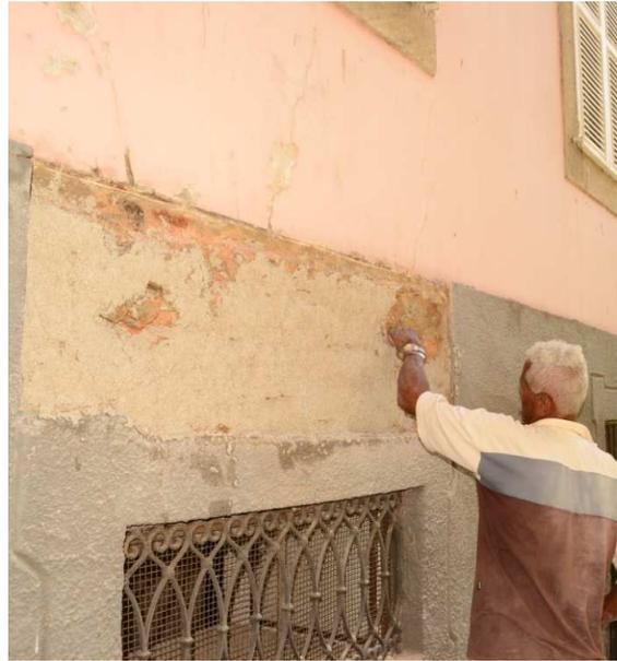
Figura 121: Primeira camada de reboco sendo aplicada (12/08/11).
