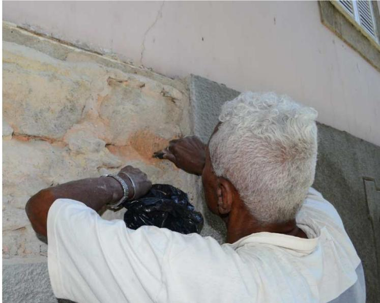
Figura 119: Argamassa de barro sendo removida para análise laboratorial (12/08/11).
