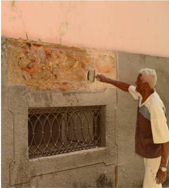
Figura 120: Parede sem umedecida para início da aplicação (12/08/11).
