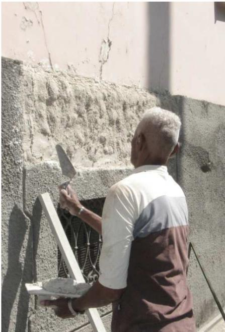
Figura 122: Segunda camada de reboco sendo aplicada (31/08/11).
