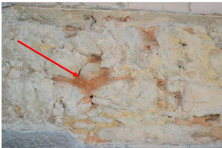
Figura 116: Presença de umidade na argamassa de barro (12/08/11).
