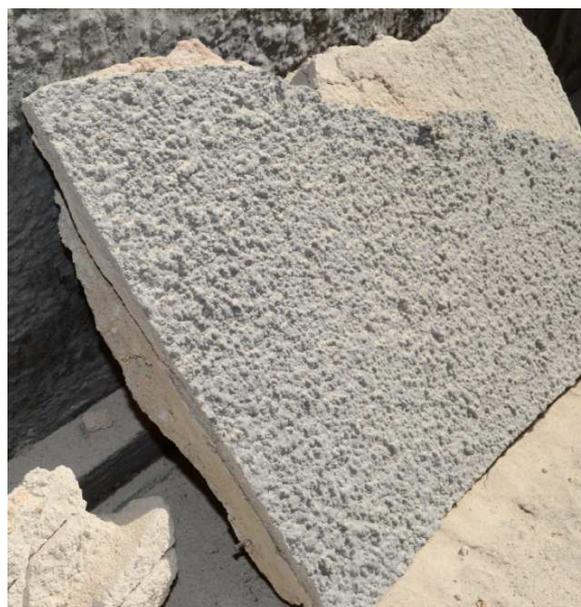
Figura 113: Revestimento sendo removido em placas rígidas (12/08/11).
