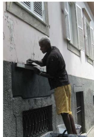
Figura 127: Acabamento final do topo do embasamento (28/09/11).
