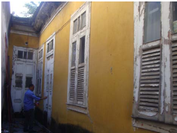
Figura 6 - Esquadrias em Madeira (518)
