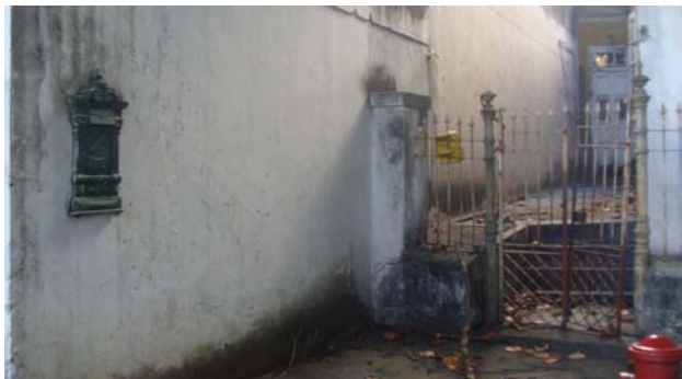
Figura 4 - Desnível no Terreno
