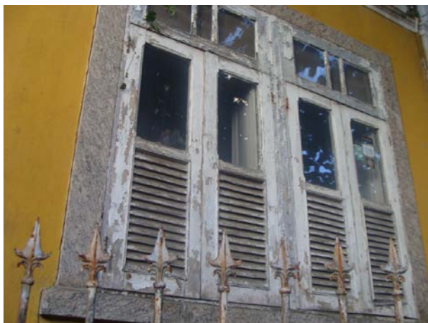
Figura 5 - Esquadrias em Madeira (518)
