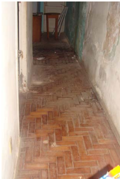
Figura 8 - Detalhe do piso em Taco de Madeira
