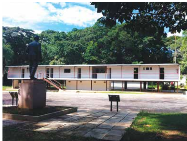
1 – Residência provisória oficial. Fachada.
