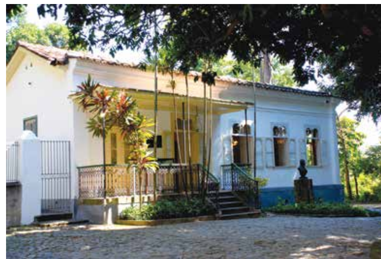
2 – Fachada principal do Museu Casa de Benjamin Constant. Arquivo MCBC/Ibram.
