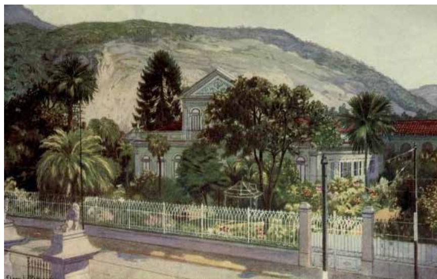
Imagem 1 – Residência do senador Rui Barbosa, rua São Clemente. Fonte: The beautiful Rio de Janeiro (1914).
